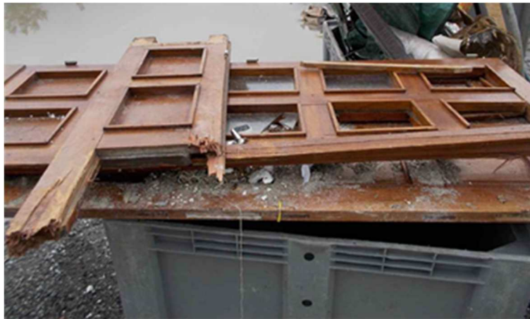
Figure 87. Portes en bois traité dans la benne d'encombrants de Guillestre.
